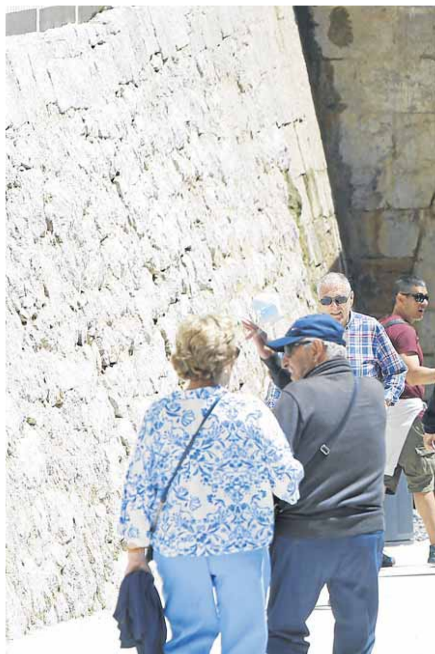
Las obras llevadas a cabo han supuesto la consolidación del antiguo túnel
